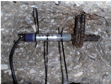
⑦照合電極設置
