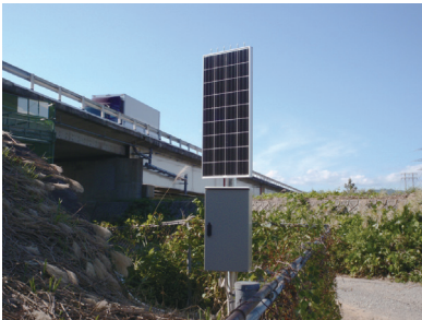
⑧ソーラー電源設置
