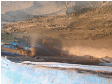
②挟隘部断面修復
