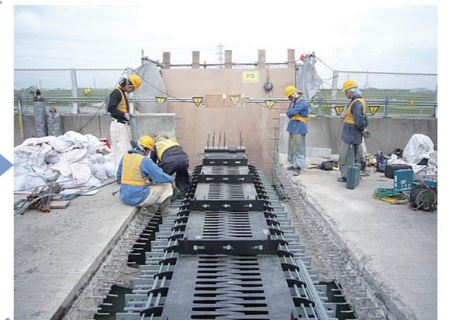
ジョイント据付け
