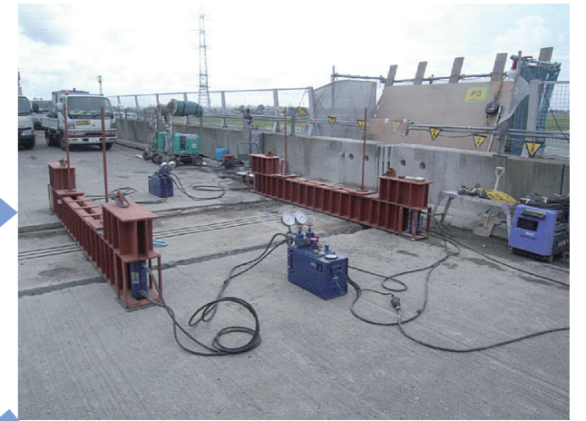
床版撤去梁設置
