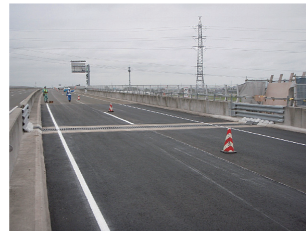
ジョイント取換完了
