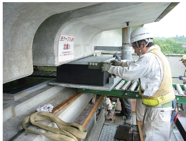
ゴム沓据付け
