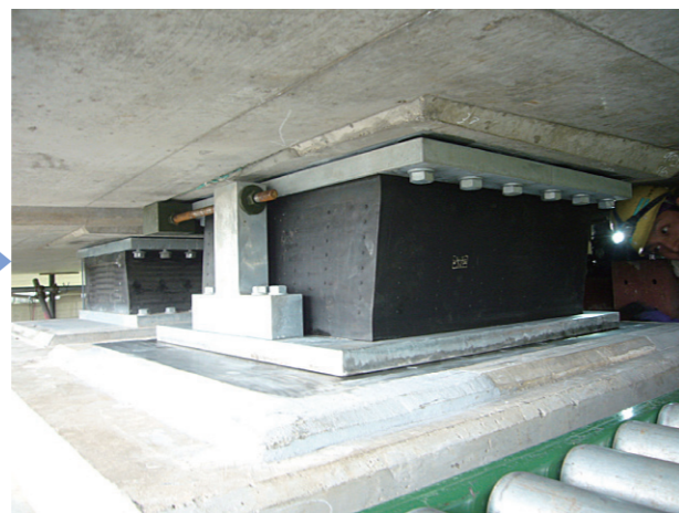
ゴム沓据付完了
