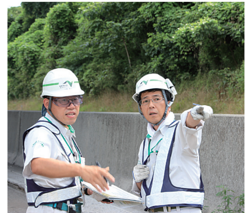
本復旧工事（舗装改良）と工事施工管理 東北道泉 IC 付近（宮城県仙台市）
