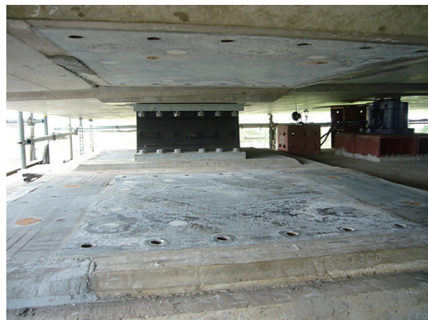
ゴム沓撤去完了
