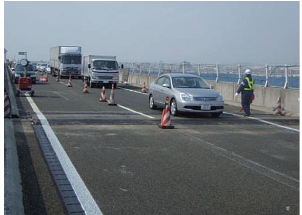
応急復旧（交通開放）
