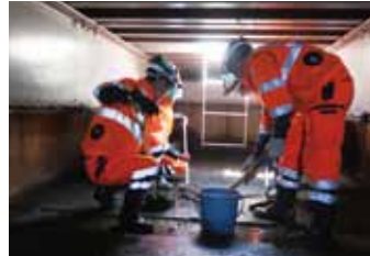
堆積物等の排出作業
