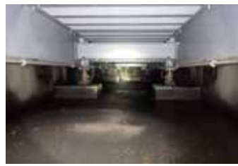
堆積物等の排出作業軽減
