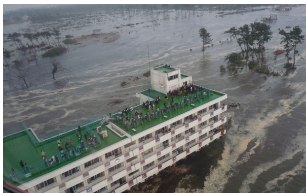
小学校に押し寄せる津波。仙台市若林区荒浜付近
